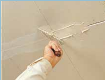
Spartling med Uniflott
